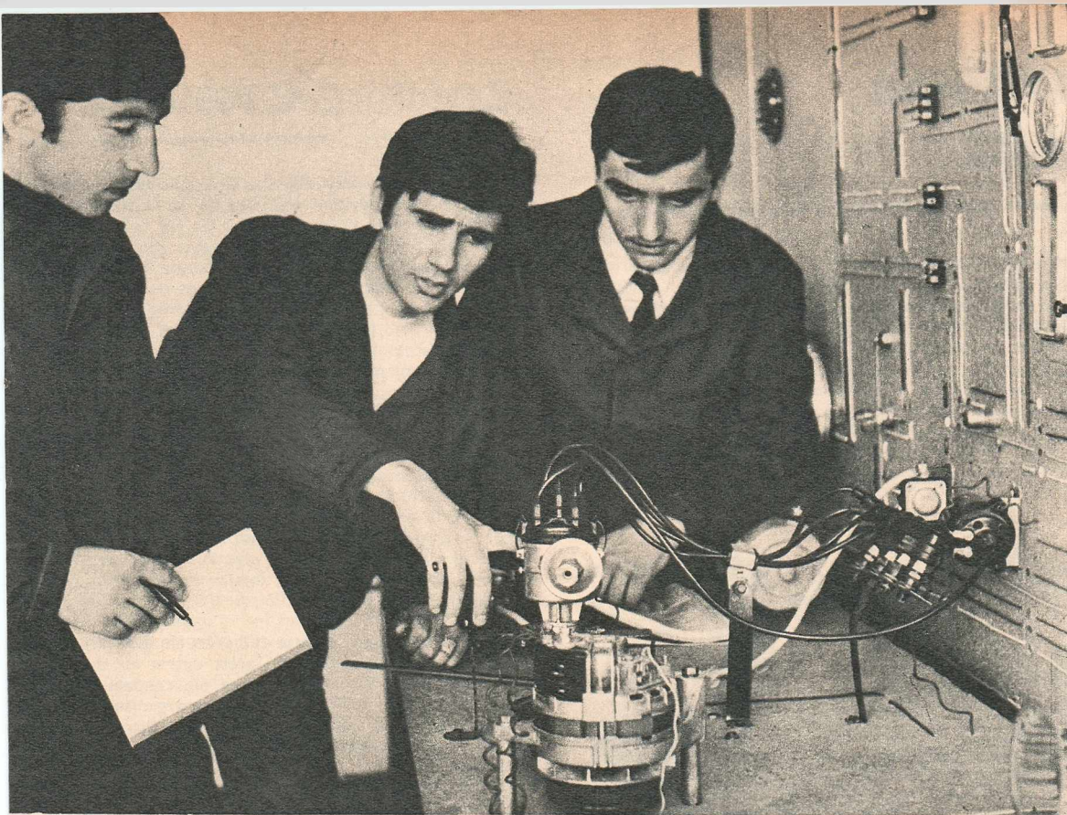
...Studierea instalației electrice a autoturismului M-461 se face pe panoplie.
