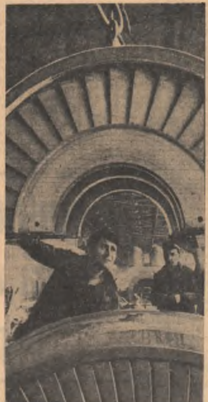
În sfîrșitul de martie anunțăm un nou succes al constructorilor montorii și energiciștilor de la termocentrala din Luduș-Iermit și au realizat cu 135 zile înainte de termen lucrările de racordare la sistemul energetic al unui nou grup de 100 M.W. Odată cu intrarea în funcțiune a noului grup electrogen, capacitatea termocentralii alungă la o putere instalată de 600 M.W. Astăzi vă prezentăm de aici un aspect al lucrărilor de montare a turbinei unui nou grup — cel de 200 M.W. Foto: Agerpres
