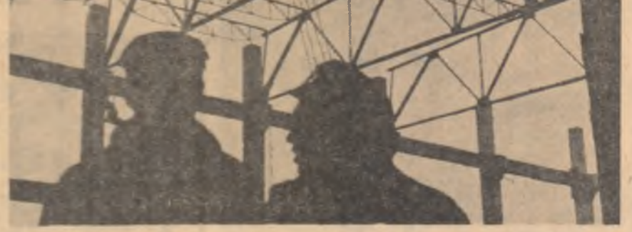
Proiectul contemporan pe cel al Craiovei. (Aspect de pe șantierul termocentralei) Foto: O. PLECAN
