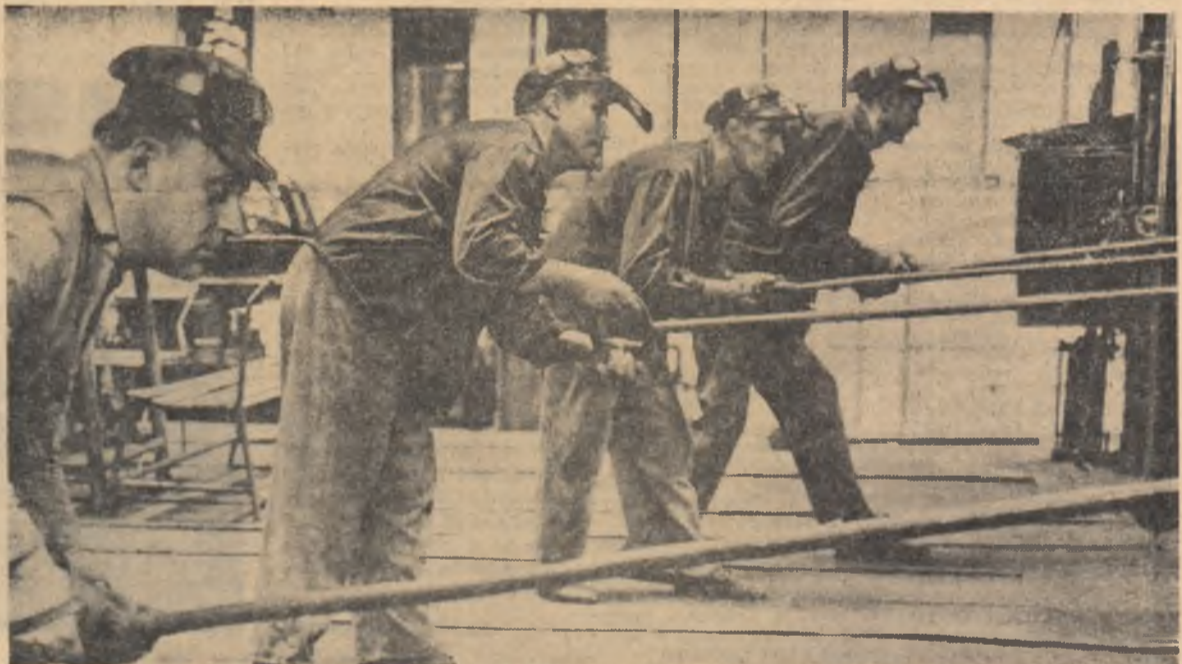
Uzinele „Republica” din Capitală. La cuptoarele laminorului de 6 folii, cîțiva membri din brigada condusă de Ion Petcu dirijînd metalul în cuprator
