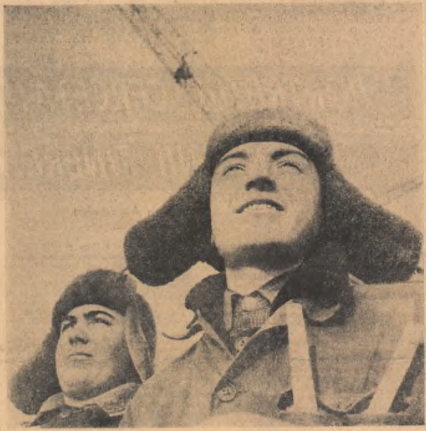
„Ne place urcusul pe verticală” — par să spună cei doi tineri FLOREA CRISTEA și VIOREL RĂCHIȚĂ — montori de colțaje spațiale. Pe șantierul I al I.C.M. nr. 3 din cartierul „Armata Poporului” s-au ridicat într-un termen scurt numeroase blocuri prin aplicarea acestei metode. Foto: O. PLECAN
