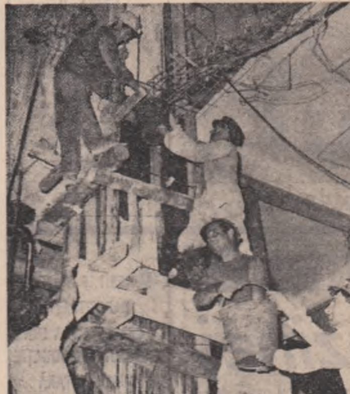
Teza zile vor sosi și betonisti și, astfel, cu efectivul dublat și în schimbul de noapte, structura de rezistență a blocului va fi terminată până la 4 septembrie. Nu este doar o dată trecută în graficul de lucrări, ci și termenul asumat de către toți cei care lucrează sau vor lucra aici: Dumitru Cocioran, Florea Calu, Gh. Duncă, Gh. Boicea...
