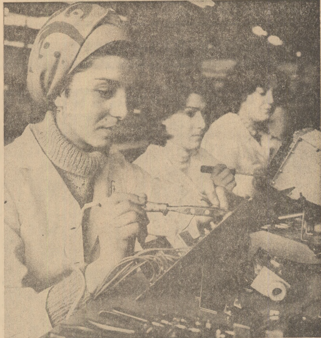
În atelierul de circuite imprimate al întreprinderii „Electrotehnica”, echipa tinerelor muncitoare electroniste condusă de Eleonora Gheroaie lucrează la un nou lot de subansamble pentru reguletoarele automate de tensiune
