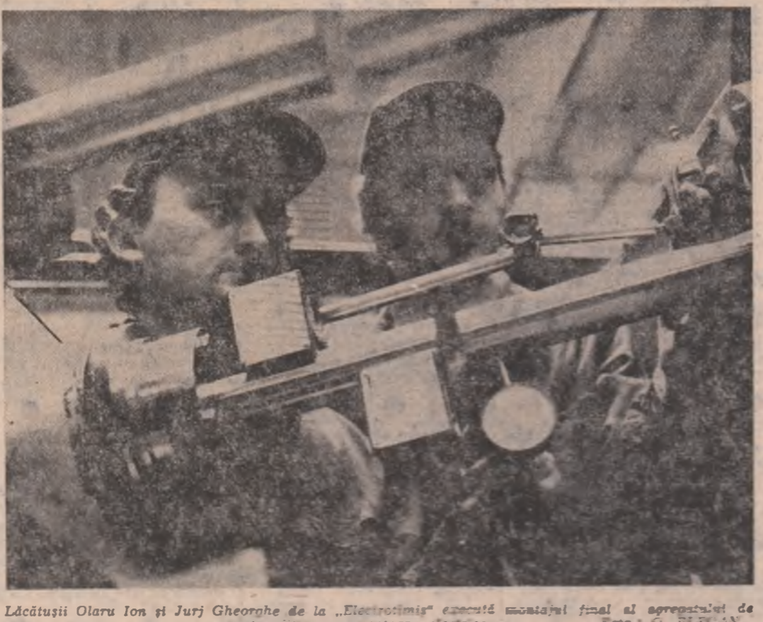
Lăcătușii Olaru Ion și Juri Gheorghe de la „Electrochim” execută montajul final al agregatelor de strînjire capace motoare electrice. Foto: O. PLECAN
