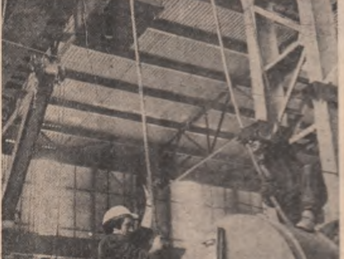
Montorii afirmă că peste câteva zile podul rulanti de 125 t va putea fi pus în funcțiune. Constructorul remarcă: lipsește doar sînta peștea caia de rulare.
