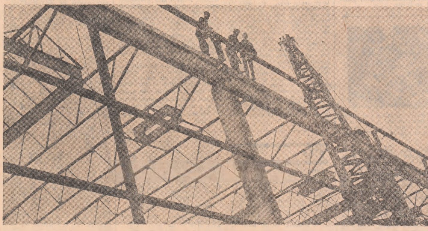
Pe șantierul de investiții al întreprinderii de utilaj petrolier din Tîrgoviște
