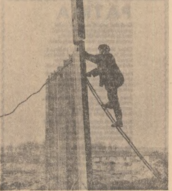
În spatele palpașelor — viitorul baraj, noua cantină și un om cu multe șantiere în inimă: șeful de echipă Alexandru Puicea
