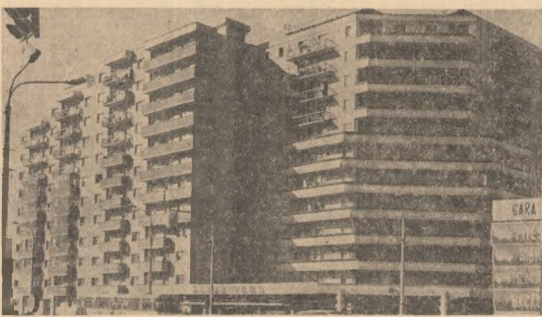
Verticalele noului cartier „Steagul Roșu” din Brașov
