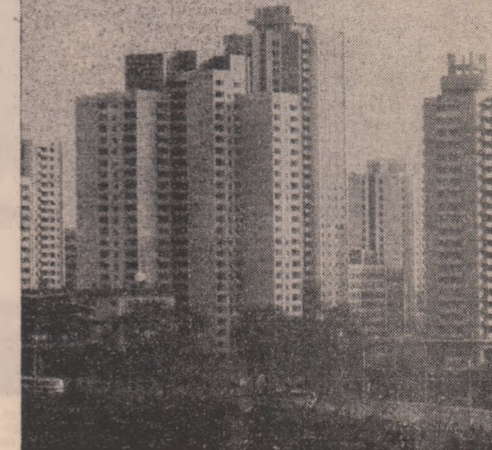
Construcții moderne la Phenia, capitala R.P.D. Coreea
