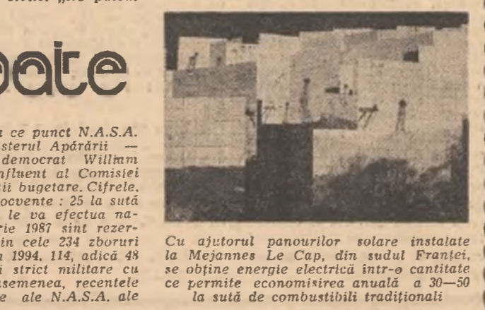
Cu ajutorul panourilor solare instalate la Mejanne Le Cap, din sudul Franței, se obține energie electrică într-o cantitate ce permite economisirea anuală a 20-30 tone de combustibili tradiționali
