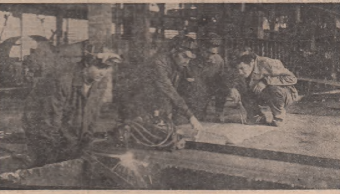
Introducerea de utilaj tehnologic în șantiere
