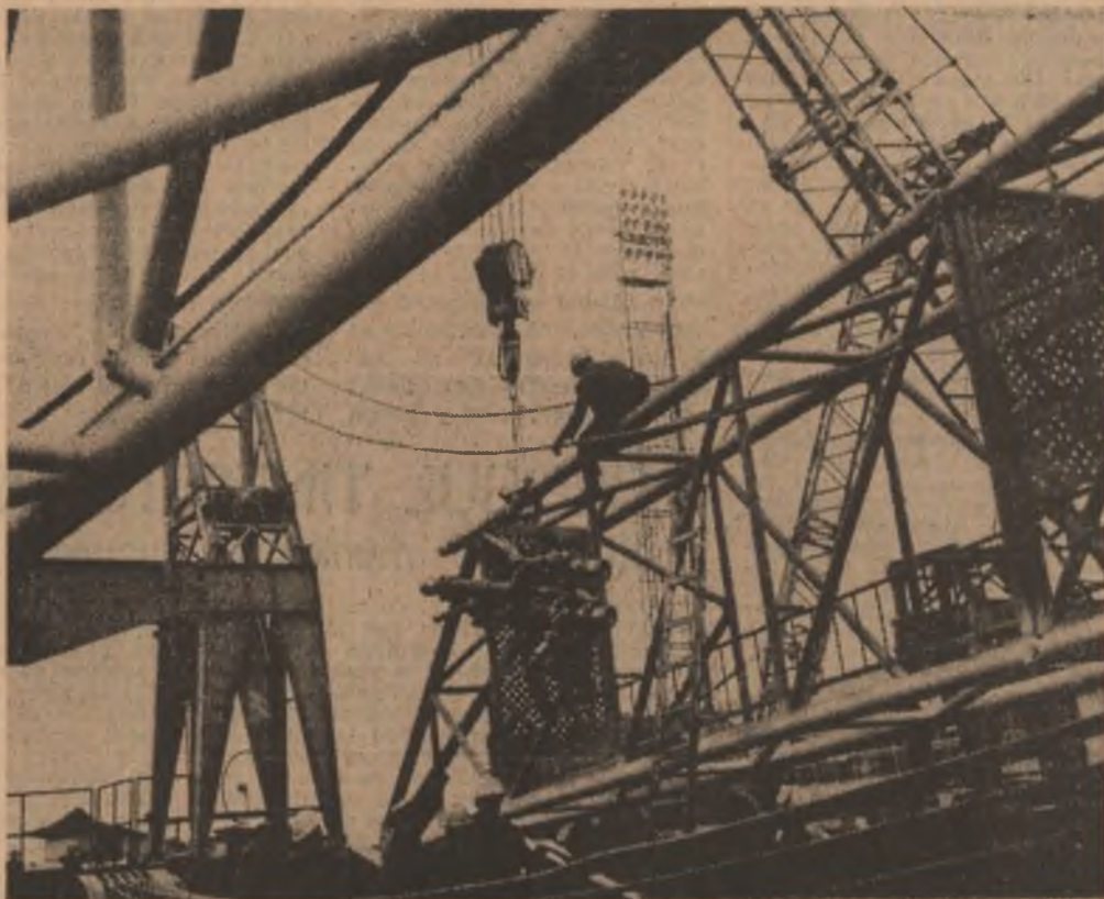
Ultimele pregătiri și complexa instalație de foraj purtînd marca „UPETROM” va fi livrată peste hotare
