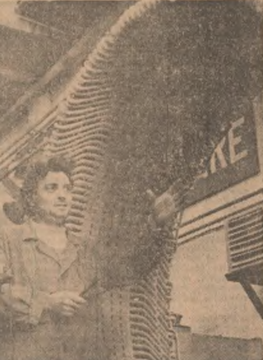
În atelierul de bobinaj greu al I.P.S.R.U.E.M. Petroșani se află în faza de finalizare un nou motor pentru compresoare
