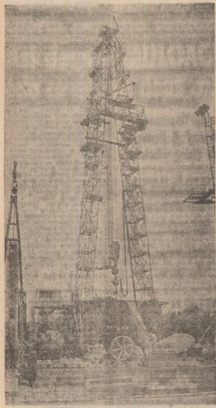
O prezentă care se impune de la sine: instalația de foraj de mare adâncime F-320
