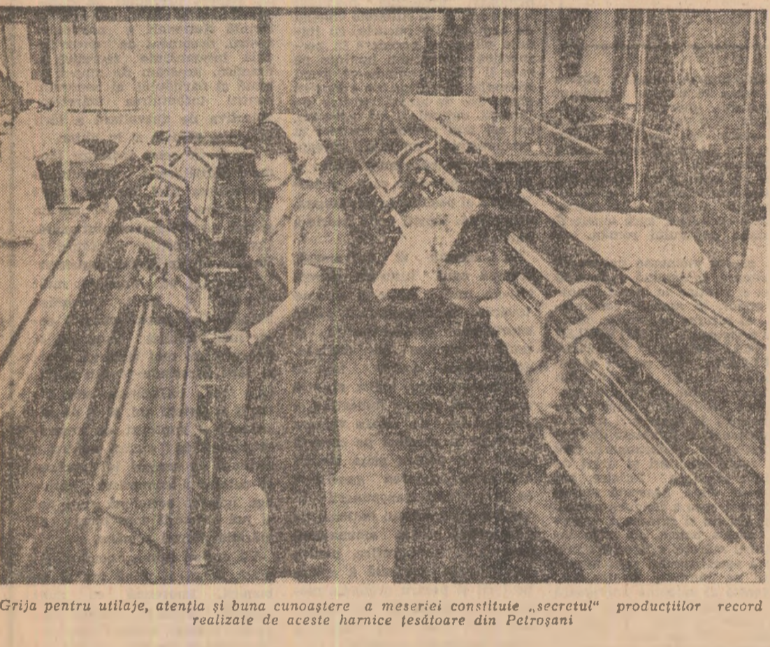
Grijă pentru utilaje, atenția și buna cunoaștere a meseriei constituie „secretul” producțiilor record realizate de aceste harnice țesătoare din Petroșani
