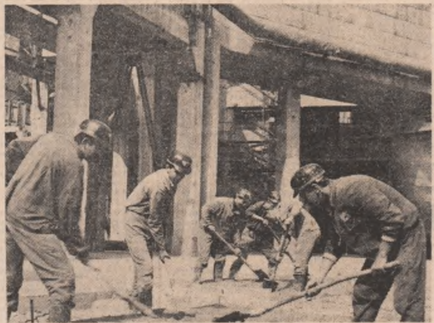
Elevii — pe măsura priceperii, dar mai ales a abnegației lor aduc o importantă contribuție la executarea lucrărilor de turnare betoane. În imagine au fost surprinși elevii ai Școlii profesionale UCBCOM Timișoara care pregătesc betoane pentru noua platformă tehnologică a viitorului atelier de reparații.
