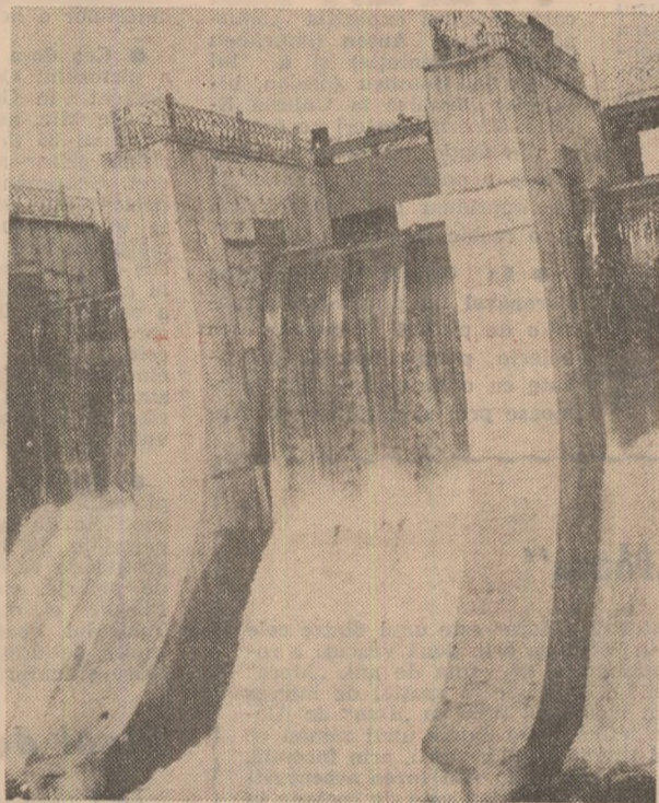
Sînt 40 de ani de la constituirea primelor șantiere naționale ale tinerețului. Una dintre operele recente ale brigadierilor, mulți dintre ei elevi și studenți, este noua Dimbovița ce traversează Capitala patriei (imagine de la barajul lacului Dimbovița).
