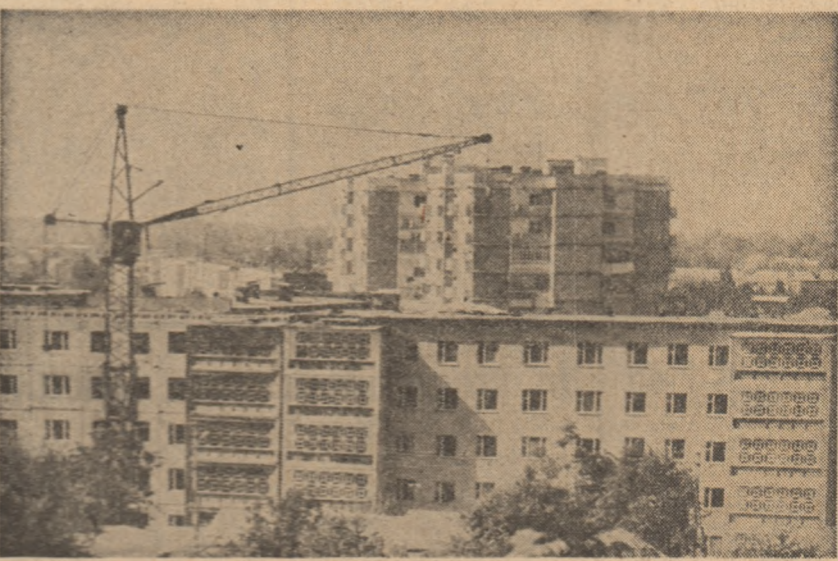
U.R.S.S. | Construcții noi de localitate la Hurgon - Tuibe, așez din tinutul Național din R.S.S. Tadjikî
