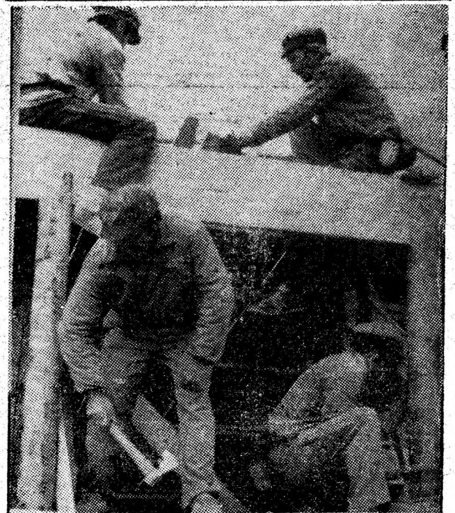
La I.M. Valea de Brazi se execută bazinele pentru apă, anexe ale stației de filtre.
