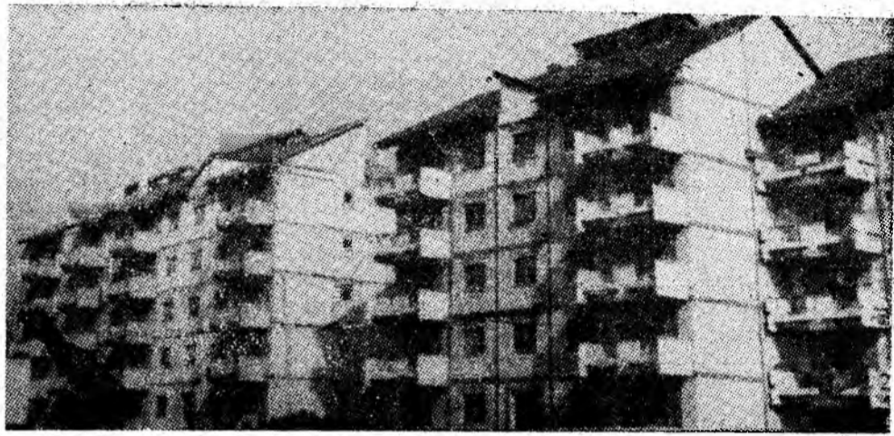
Prin construirea primelor blocuri de locuințe, în Iscroni, orașul Aninoasa, s-au făcut pași însemnați în direcția îndeplinirii planului de sistematizare a localității. Foto: Gh. OLTEANU
