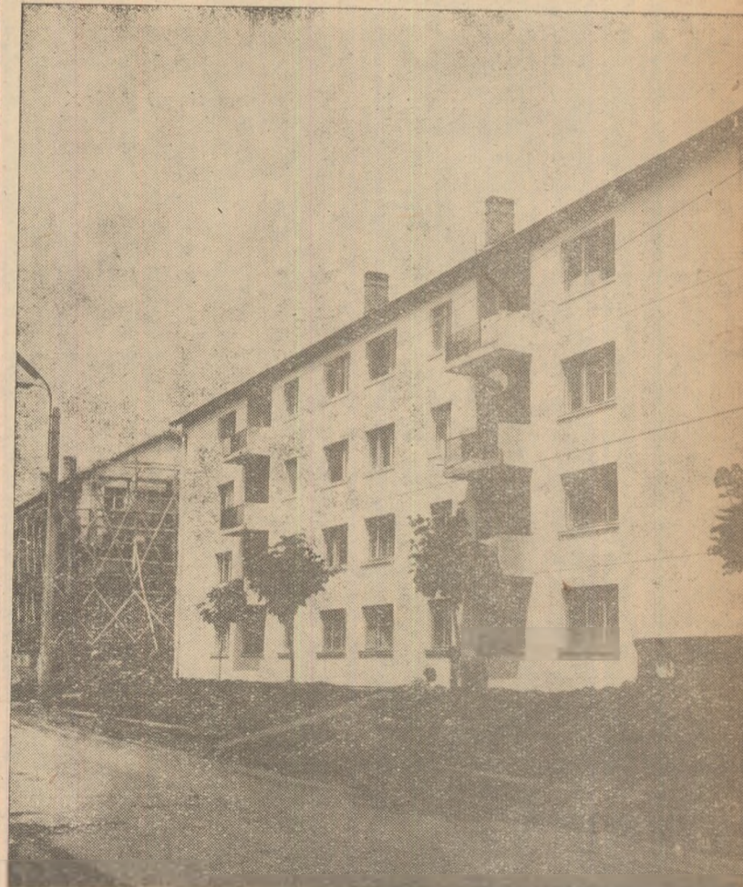
La 11 mai a.c. muncitorii de pe șantierul nr. 4 construcții civile I.C.S. au dat în folosință oamenilor muncii din orașul nostru alte 3 blocuri un număr de 80 apartamente.
